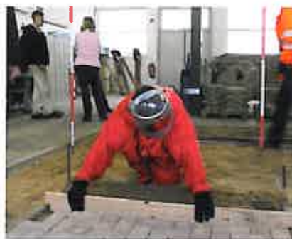
Auszubildender in Alterssimulationsanzug bei der Verlegung von Pflastersteinen.
