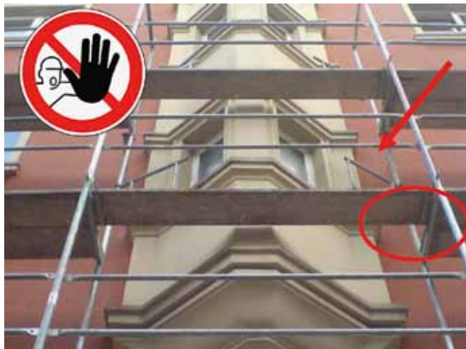
Fassadengerüst fehlende Bordbretter, Verwendung nicht geeigneter Gerüstbauteile für die Absturzsicherung, mangelnde Eckausbildung
